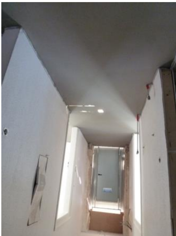
Eingang zur Wärmestube mit Bautür
