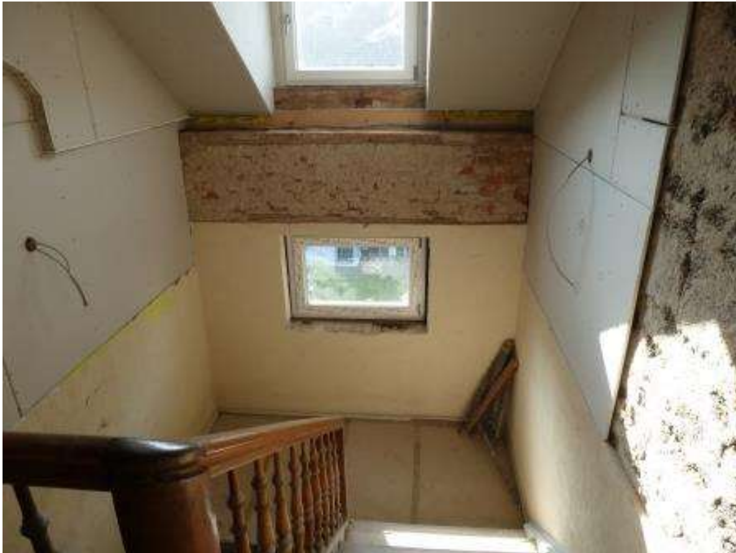
Das Treppenhaus aus dem DG
