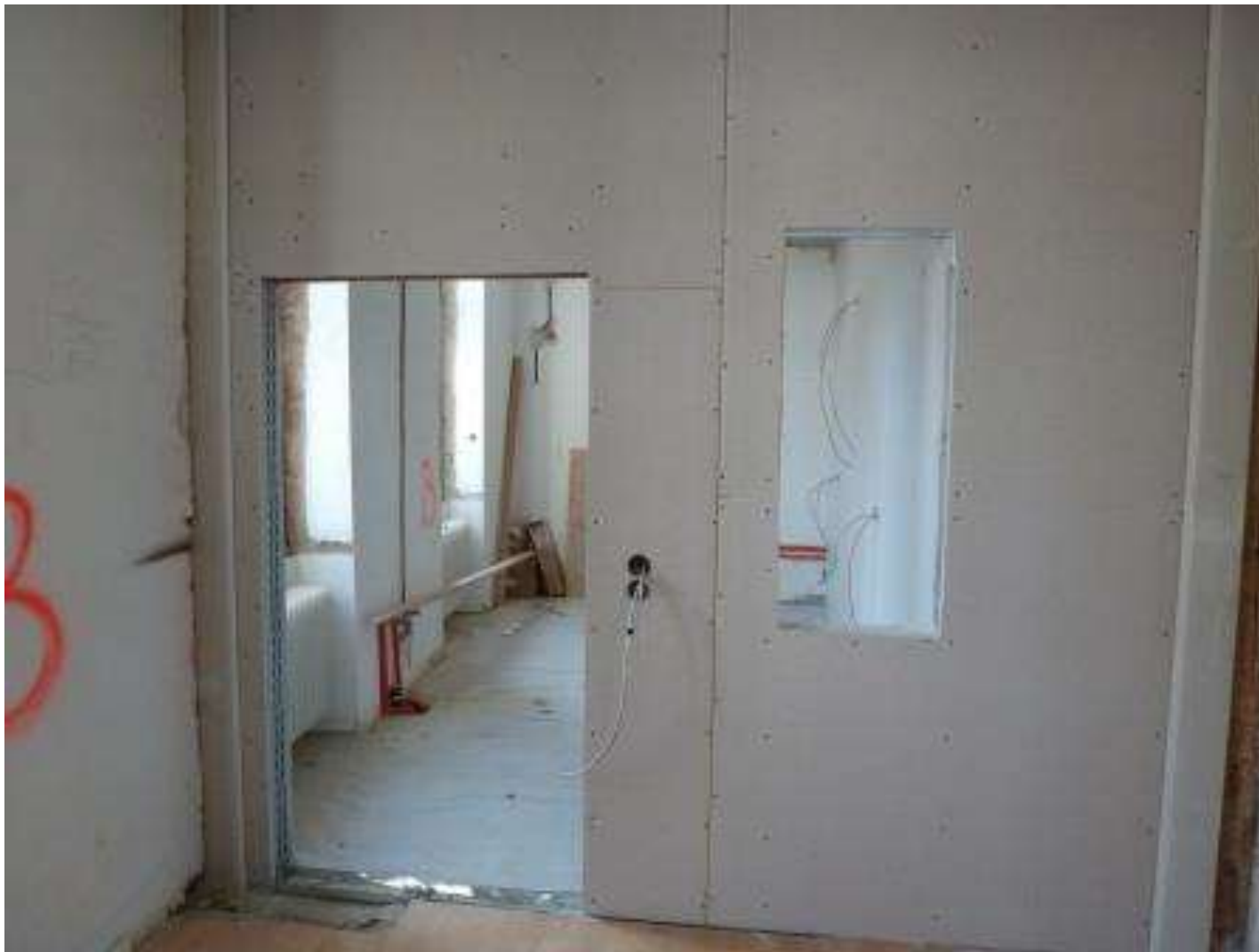
Der Blick in die neue Küche vom Aufenthaltsraum aus
