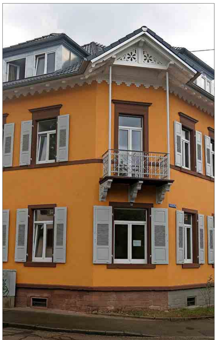
Die neue Wärmestube in der Hochburgerstraße.
